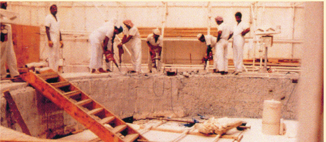
Proses renovasi pada tahun 1996.
